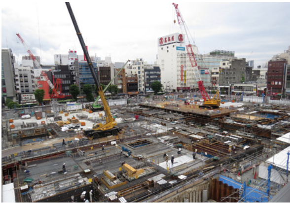
写真2：大門町2丁目再開発現場（当研究所撮影）
