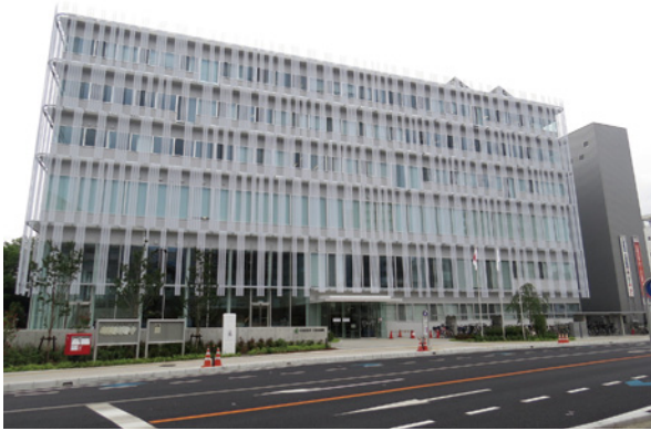
写真3：2019年5月にオープンした新しい大宮区庁舎と大宮図書館（当研究所撮影）
