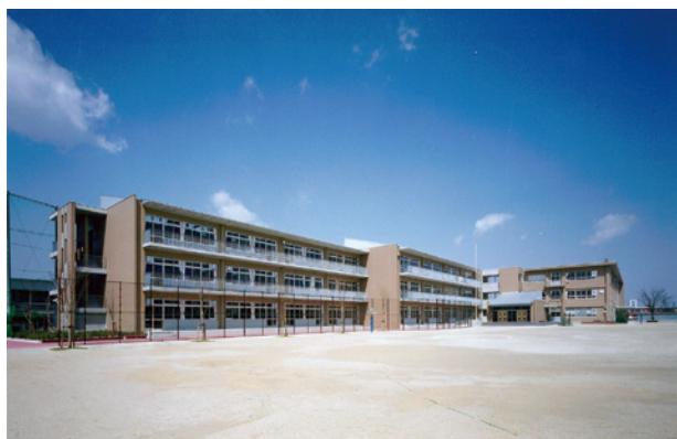
写真3：四日市市立 橋北中学校全景
