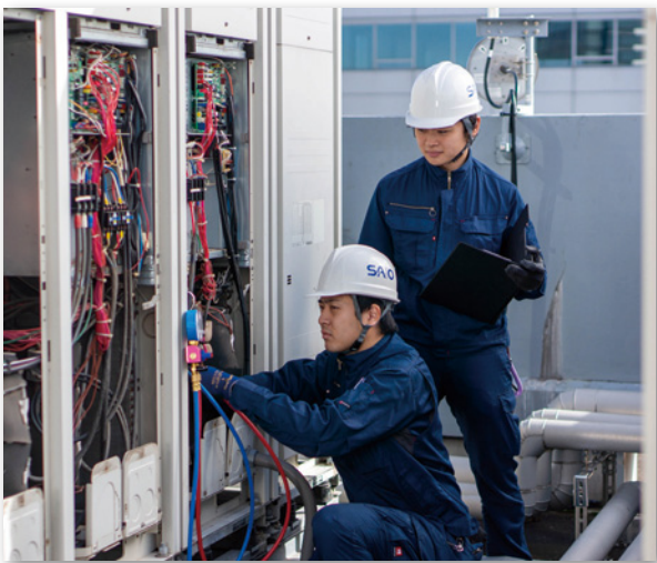
空調設備保守点検
