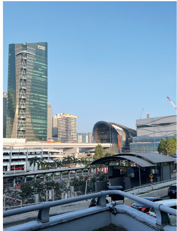
建設中のJBセントラル駅
