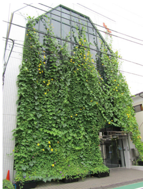
ルケオ本社ビルの緑のカーテン
