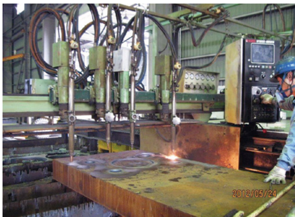
ガス溶断の風景
