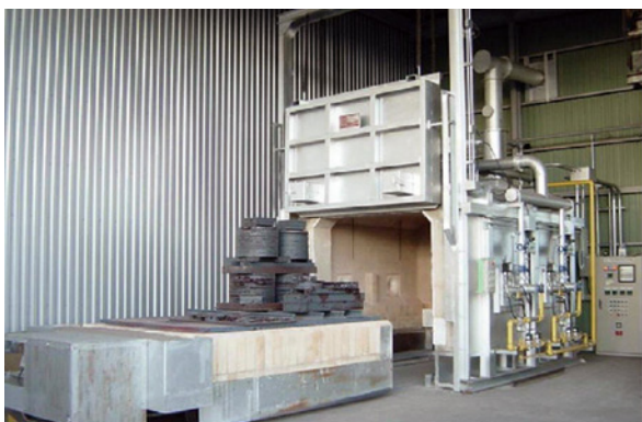
焼鈍炉での作業風景
