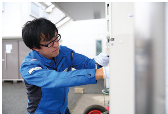
プロパンガスの点検風景
