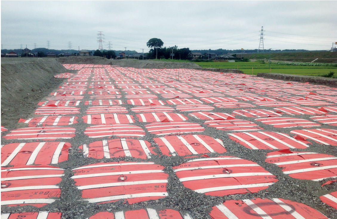
施設基礎下の地盤補強例
