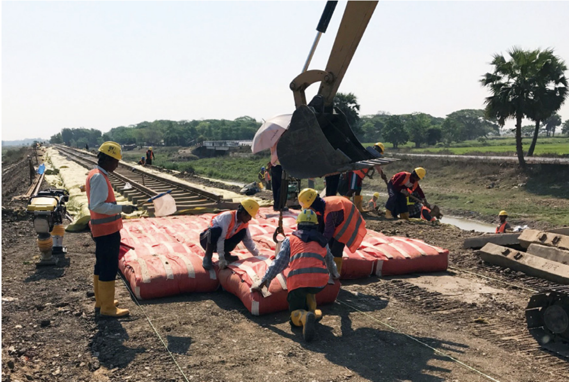
ミャンマー鉄道工事例
