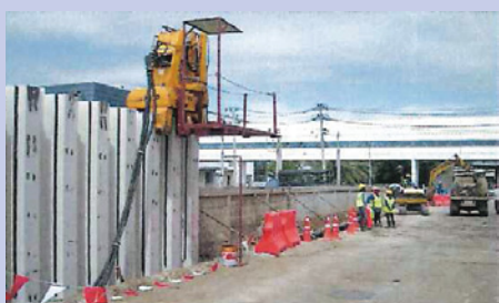
タイ王国での洪水対策防水壁設置工事
