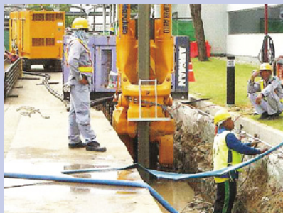
タイ王国での洪水対策防水壁設置工事
