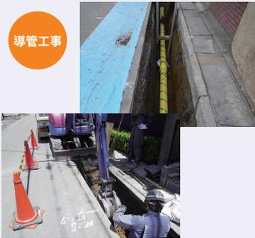
●都市ガスは、道路の下のガスパイプラインを通して、ご家庭に運ばれるのですが、そのガスパイプラインの施工などを行うのが導管工事です。
