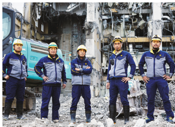
解体工事現場作業員の皆さん
