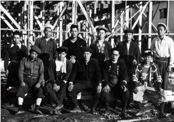
昭和40年代の解体現場
