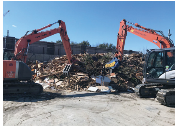
パンぷキン・デポでの作業風景
