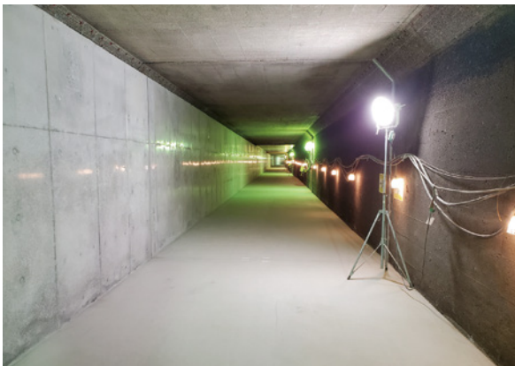
土木事業 南部流域処理場の放流渠耐震化工事
