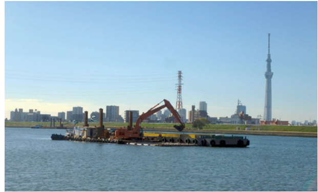
土木事業 荒川下流堀切地区浚渫工事
