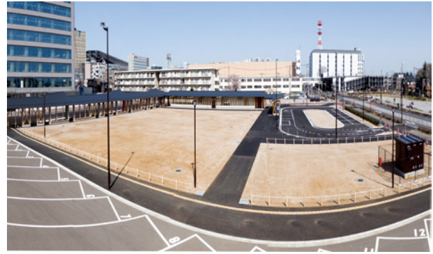
土木事業 さいたま新都心バスターミナル暫定整備工事
