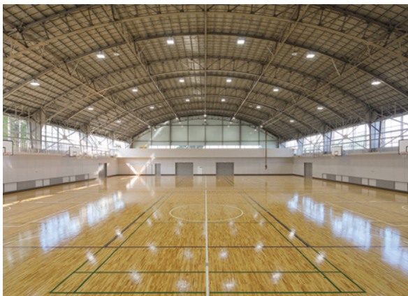
建築事業 川口工業高校体育館ほか全体改修工事
