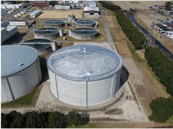
土木事業 行田浄水場 PC 浄水池築造工事
