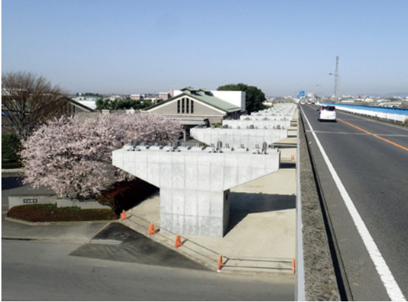
土木事業 国道50号新川島橋下部
