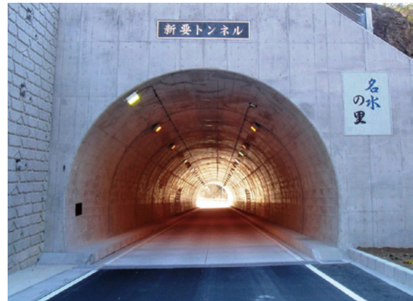
土木事業 小鹿野町の新要トンネル築造工事
