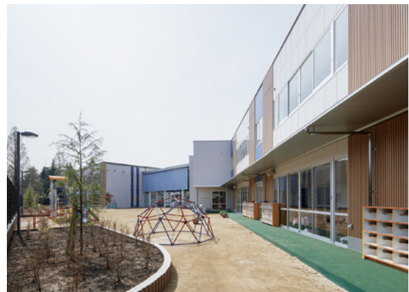
建築事業 幼保連携型認定こども園新築工事（三郷市）
