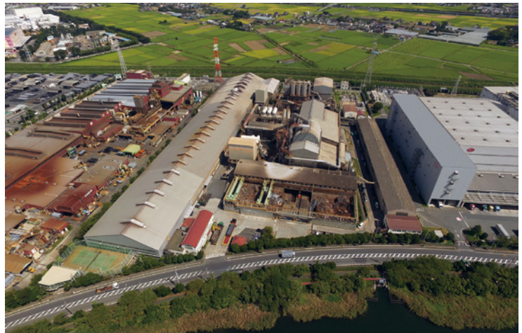
1976（昭和51）年に建設した久喜工場。その後も幾度かにわたり、設備の改善・改良を目的にリフレッシュ工事が行われ現在に至っている。
