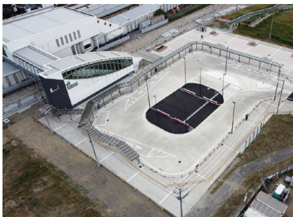
JR 武蔵野線 吉川美南駅ロータリー施工完成時
