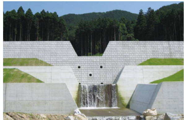
SBウォール工法にて建設した砂防
