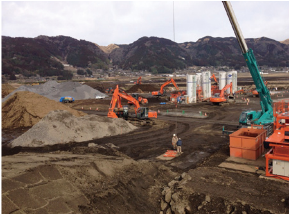
熊本県災害復旧事業の集中プラント方式
