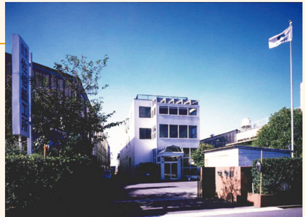
1995年に新設・増設された白岡工場は同社の技術の源である
