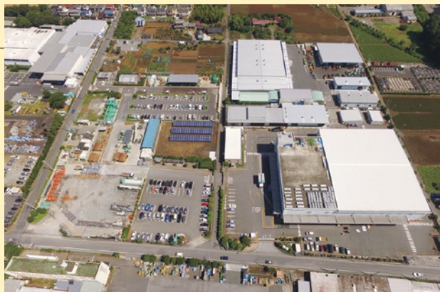
本社・入間トラストセンターの全景
