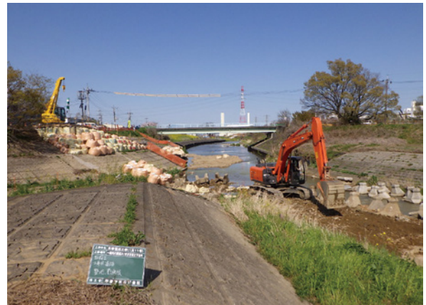
柳瀬川災害復旧工事
