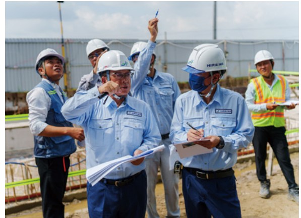
ベトナムの現場での中間検査
