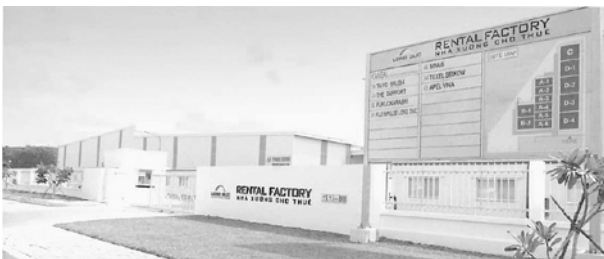
4タイプのスペースが用意されたレンタル工場
