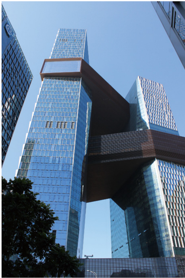
テンセントの新社ビル
