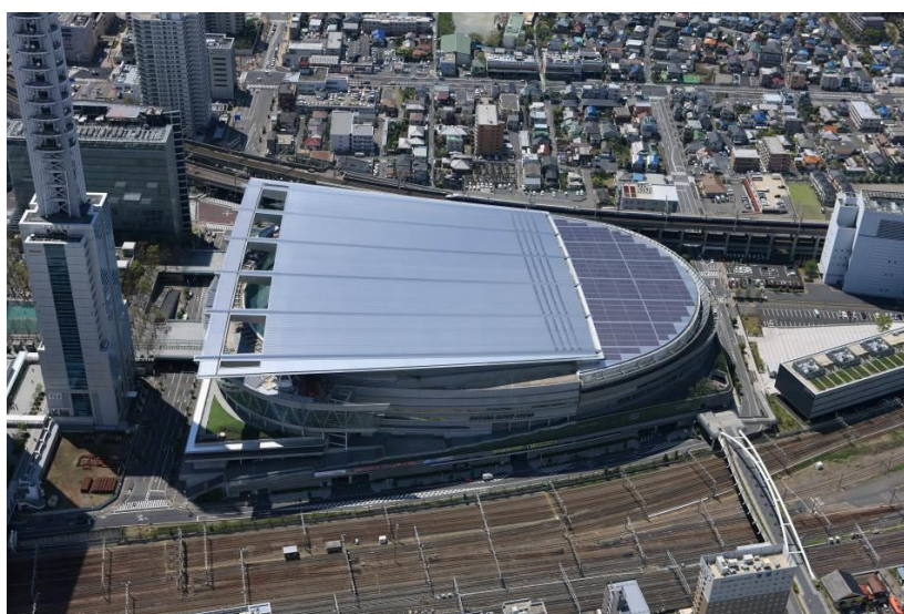
「さいたまスーパーアリーナ」の全景 写真提供：埼玉県
