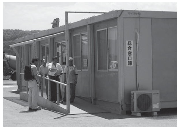
被災証明等を発行する仮設庁舎
