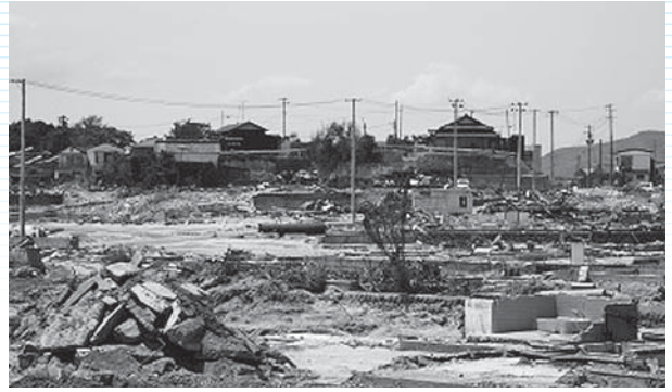
写真② 多くの住宅等が流出し、人命が失われた原釜・尾浜地区
