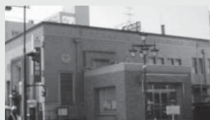
昭和初期に竣工した銀行の店舗
