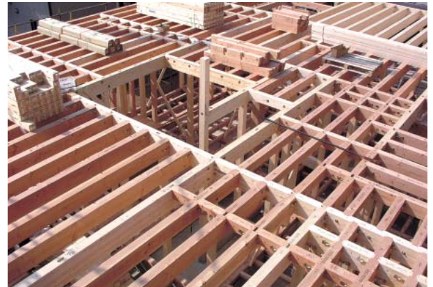
当社が開発した地震・台風強い構造の「スーパーウッド工法」(左)と実際の施工例
