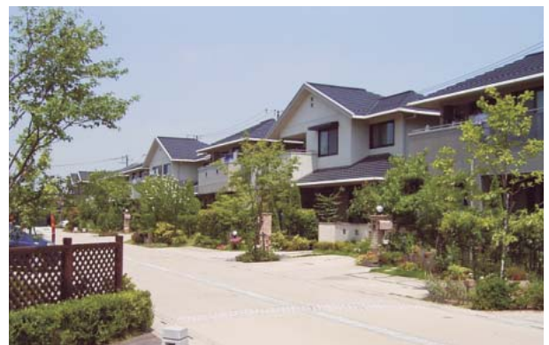
快適な住宅地の整備（伊奈町中部地区）
