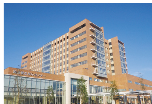
地下1階、地上11階、503床の規模で、最新設備を有す「県立がんセンター」。県民のがん克服の期待を担います。
