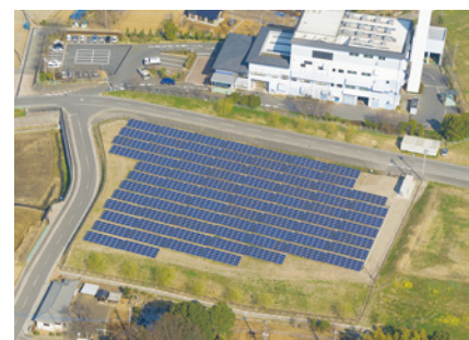
大規模太陽光発電施設「杉戸ソーラーウェイ」 ●発電出力：532kW ●年間発電量：約570,000kWh ※一般家庭の約150世帯分に相当
