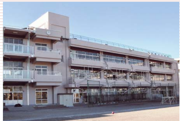
大規模改修工事を終え、各普通教室などに空調設備を整備した志木第三小学校
