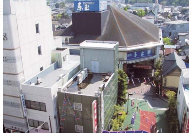
総本店ビルから見た東玉総本店新館
