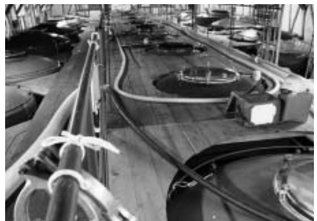
看板銘柄の白扇などがこの酒造タンクで製造されている
